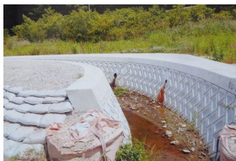
河川の改修工事
